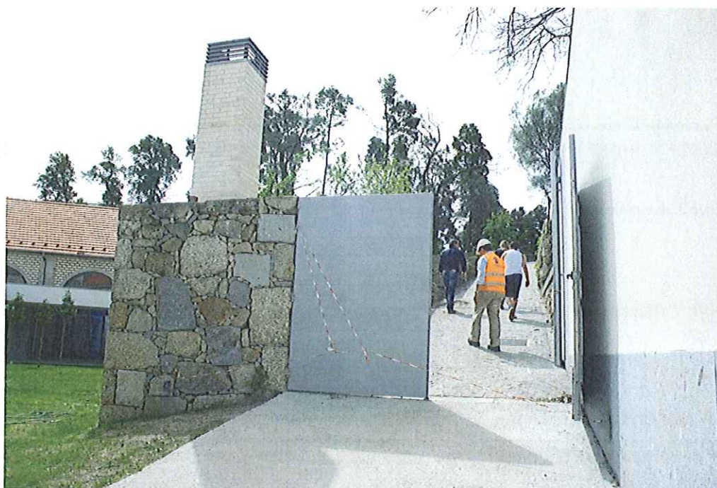
Img 8: Casa das máquinas de apoio ao Bloco D
