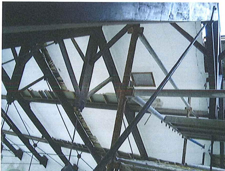
Img 9: Teto do ginásio antes da intervenção
