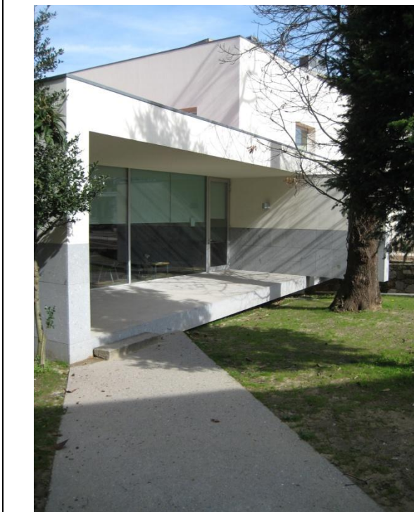
15 - Edifício B - alçado Sul (cafetaria).
