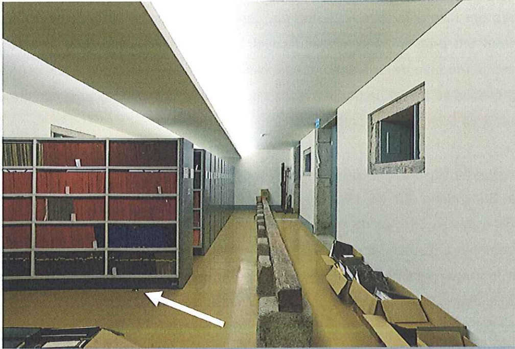
Img 23: Zona de arquivo após intervenção
