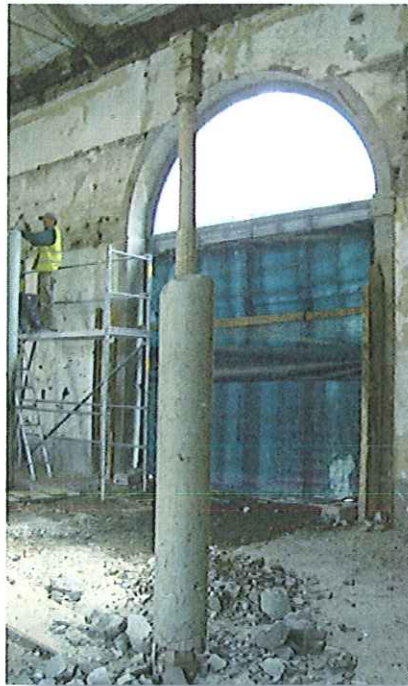
Img 17: Execução dos trabalhos de reabilitação de vãos
