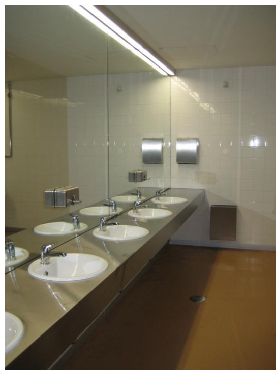
20 - Edifício B - instalação sanitária.
