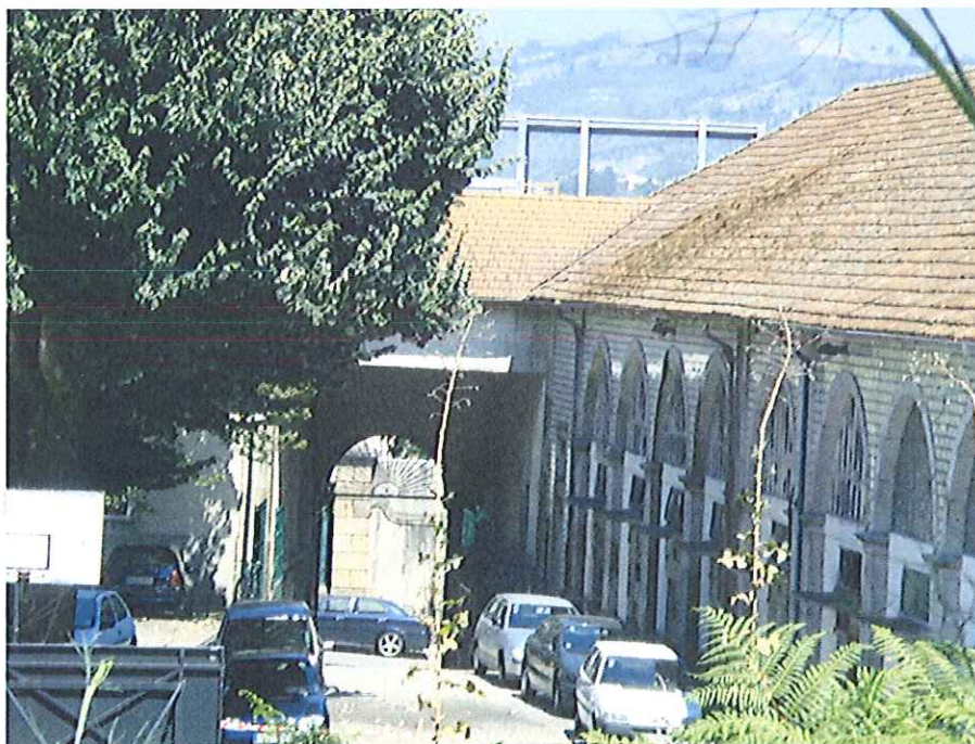
Img 26: Único local de entrada de veículos, a qual não permitia a passagem de camiões
