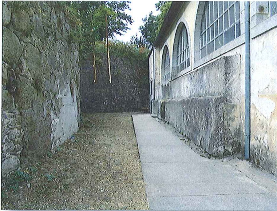
Img 4: Muros existentes previamente à intervenção
